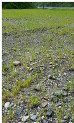
Figur 6-1b: Eksempel som synliggjør hvordan det kan gå når toppdekket og oppbyggingen av lagene ikke ivaretar ønsket kvalitet
