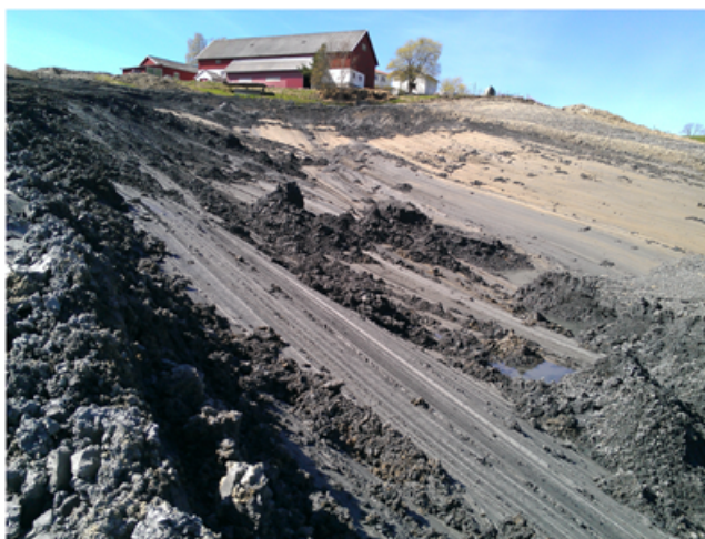
Figur 5-5: Massehåndtering krever god kontroll med mange forhold, herunder grunnforhold. På bildet skapte leire i grunnen uforutsette utglidninger som følge av tilførsel av jordmasser på frossen leire (ikke kvikkleireskred).
