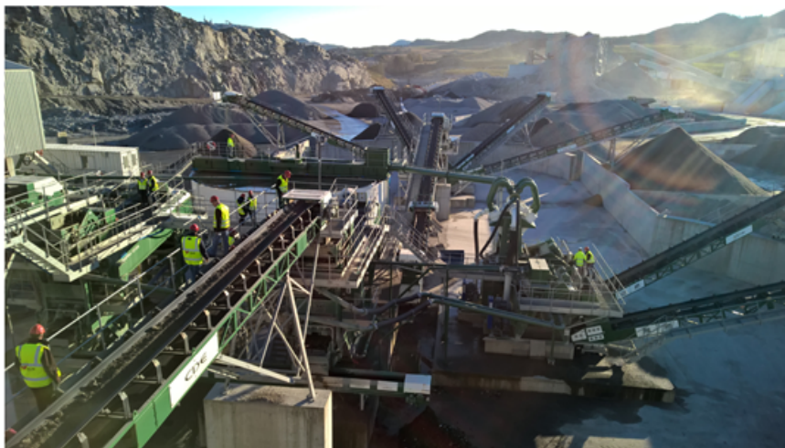
Figur 5-12: Miljøanlegget på Velde som vasker og sorterer gravemasser og gir tilbake høyverdige råstoffer som ellers hadde blitt deponert.
