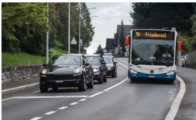
Figur 5 Spitalstrasse i Luzern ( Erste, elektronische Busspur im Kanton Luzern: In der Rush Hour fährt der Bus links (luzernerzeitung.ch) )
