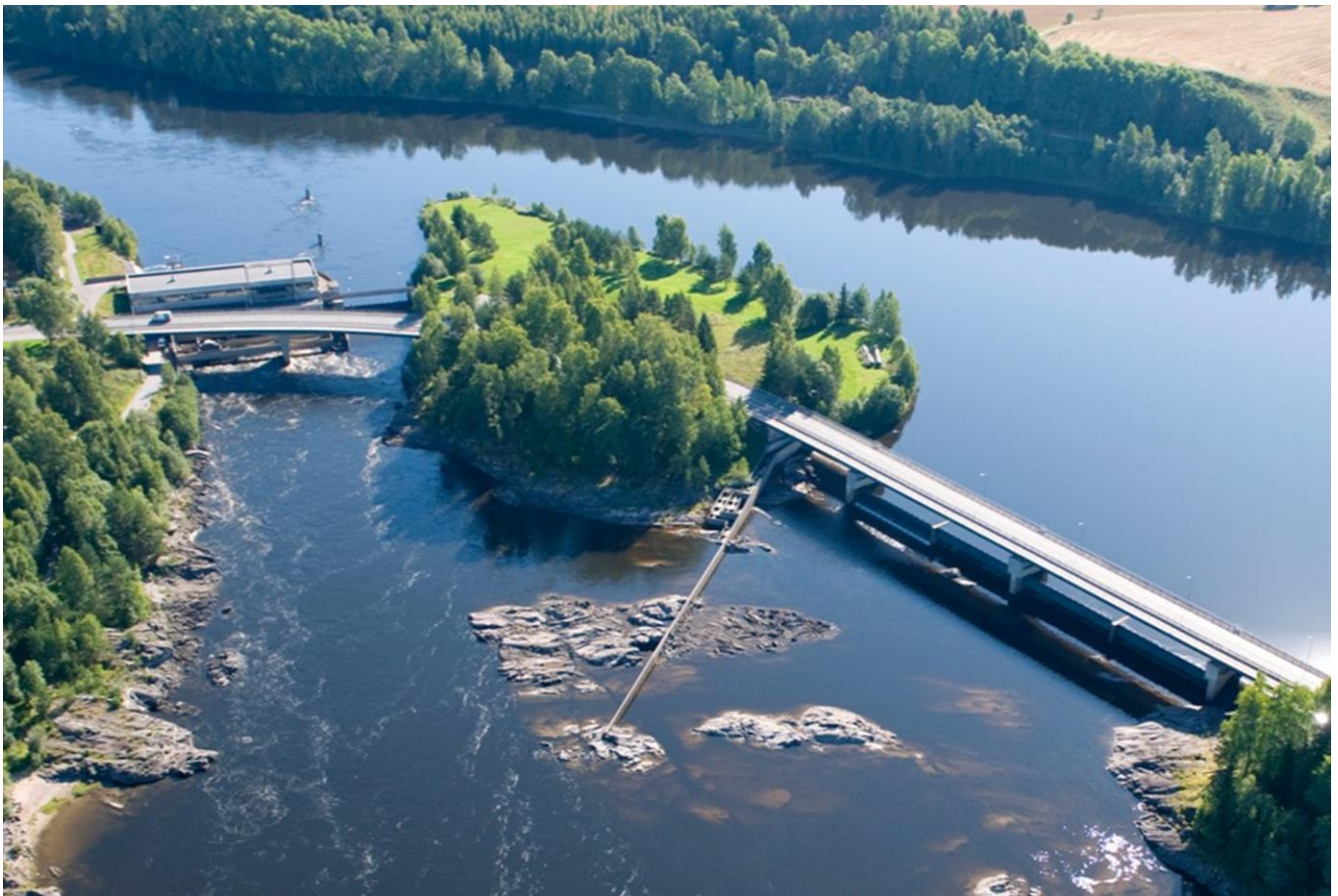
Foto: Bingfoss Kraftverk/ Akershus Energi
