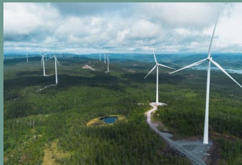
Figur 4-5: Odal vindkraftverk. Kilde: energiwatch.no
