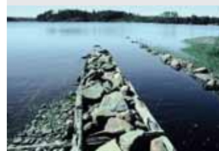
D: Tømmerrenna i Hvervelva i Aurskog-Høland ble bygd i 1890 og er en del av Sootkanalen. Her ved utløpet i Setten. Fotograf: Trond Taugbøl
