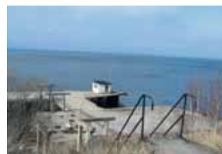
C: Svestad brygge på Nesodden var dampskipsbrygge fra slutten av 1800-tallet. Foto: Akershus fylkeskommune
