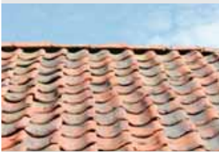
7.2.9: Enkeltkrum uglassert takstein av tegl på husmannsplassen Engerholm i Enebakk. Foto: Akershus fylkeskommune
