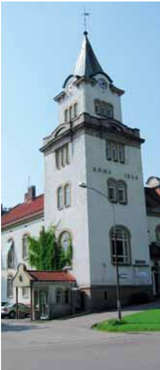
7.2.17: Behandlingsinstitusjonen Dikemark i Asker eies av både Oslo kommune og staten. Administrasjonsbygningen er fra 1908. Foto: Akershus fylkeskommune
