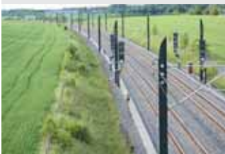
O: Den nye jernbanen til Gardermoen åpnet i 1998. Foto: Akershus fylkeskommune
