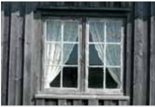
7.2.9: Vindu med to rammer og tresprosser med kittfals på husmannsplassen Engerholm i Enebakk. Foto: Akershus fylkeskommune
