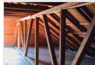
7.2.9: Sperretak med takstol i verneverdig bygning på Sør-Gardermoen. Foto: Akershus fylkeskommune
