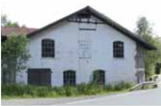
G: Børter elektrisitetsverk fra 1914 ved elva Igna i Kirkebygda i Enebakk. Foto: Akershus fylkeskommune
