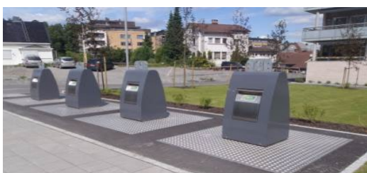
Avfallssystem med trinnfri atkomst.
