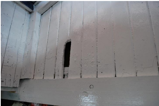
Skylight med tydelig opprinnelig, innvendig panel.
