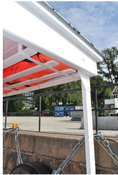
Takoverbygg, stålprofil og stender – SB-side.
