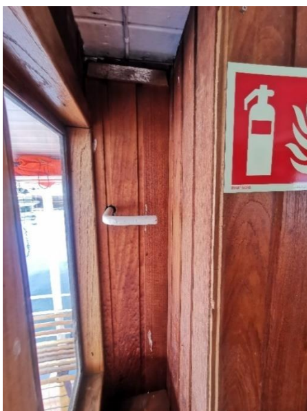
Spak til å lukke utvendig skilledør babord side.
