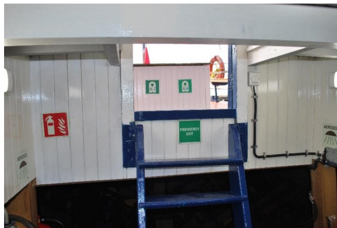
Øverste del av leder og bakre innervegg nedgangskappe ved skylight.
