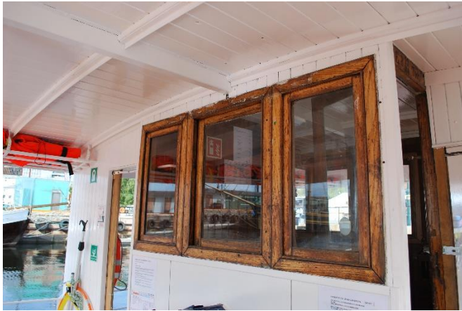
Opprinnelige vinduer i front
