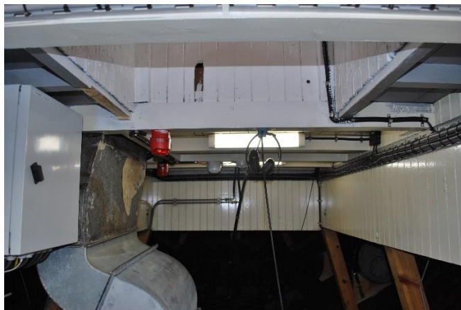
Skylight og eksos/kjøleluftkanal.
