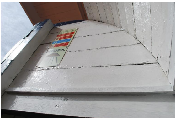
Nedgangskappe BB-side, skylight. Opprinnelig kledning.
