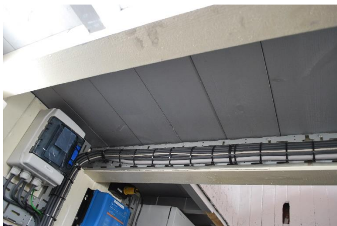
El.gjennomføringer – tak skylight/nedgangskappe
