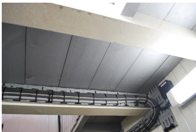
El.gjennomføringer – tak skylight/nedgangskappe
