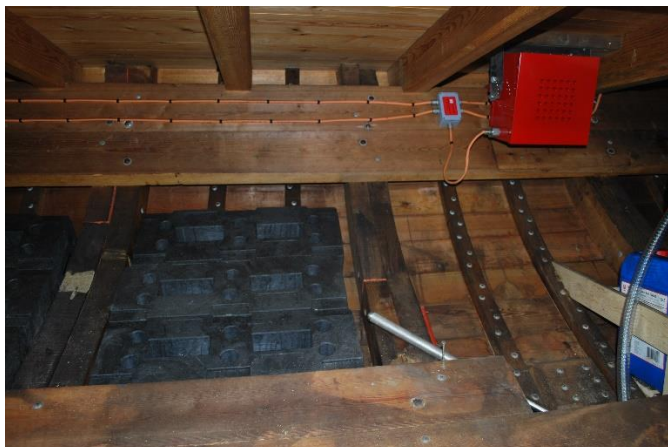
Ballast og spant – BB ved skylight.
