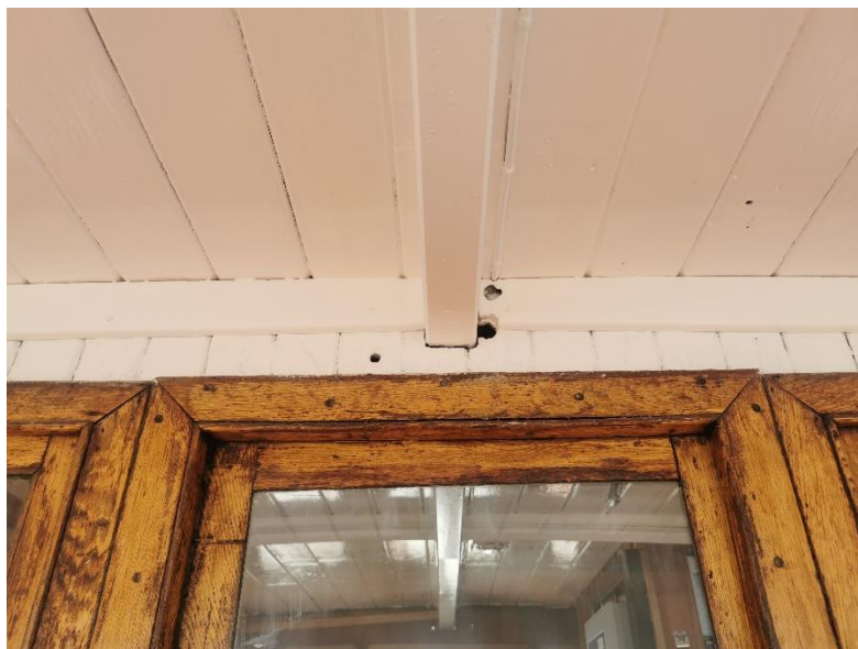
Rammer rundt frontvinduene.
