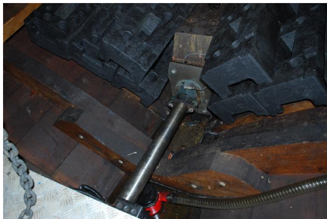
Akselgjennomføring fra motor til propell
