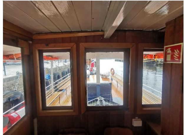
Tak og vinduslister.
