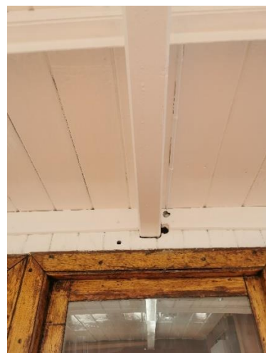
Bærende konstruksjon, takoverbygg.
