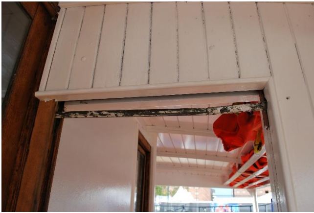
Åpning i skillevegg med skyvedør.
