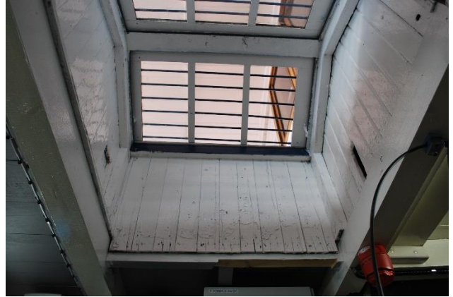
Skylight. Kledningen rundt er opprinnelig.
