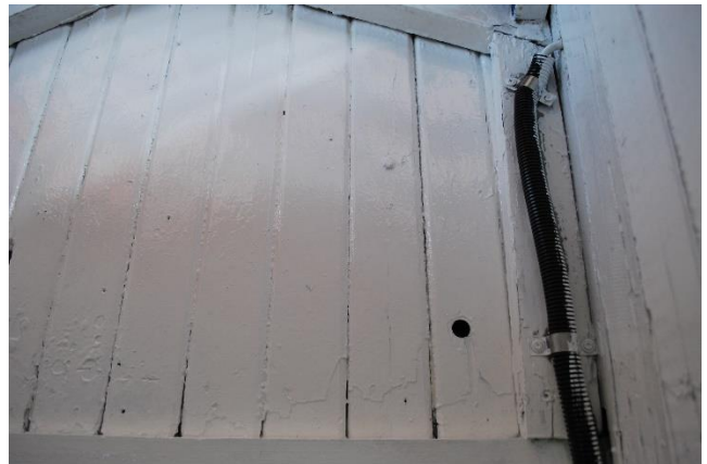
Skylight – opprinnelig, innvendig panel.
