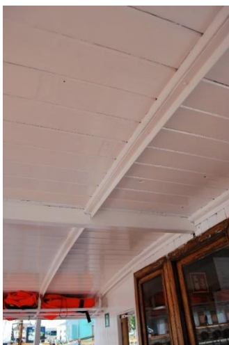
Bærende konstruksjon, takoverbygg.
