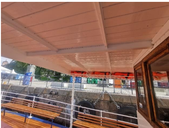
Takoverbygg – innvendig, SB-side forut.
