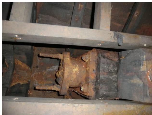
Opprinnelig pakkboks forut.
