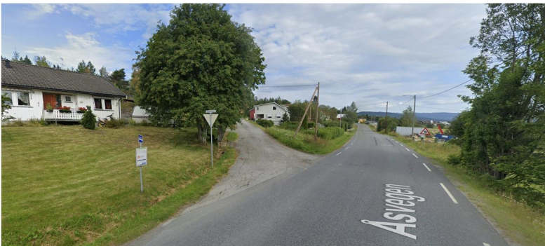
Figur 1.6: Kryss mellom Åsvegen og Kåråsenvegen mot sør. (Google maps 2023)
