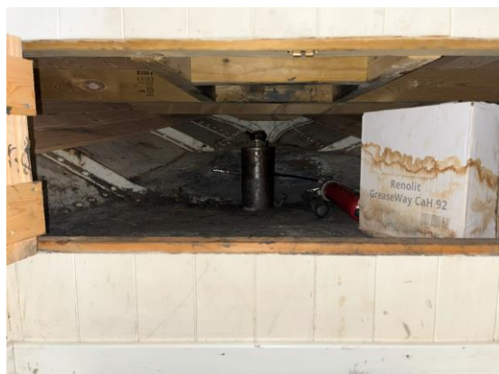
Tilgang rorgjennomføring under tunnelinngang akter.
