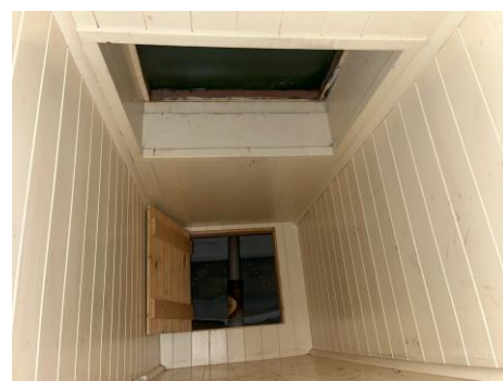
Inspeksjonsluke inn til akterpiggen.
