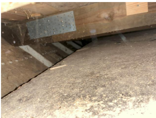
Betongballast under mannskapslugar.
