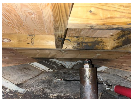
Tilgang rorgjennomføring under tunnelinngang akter.
