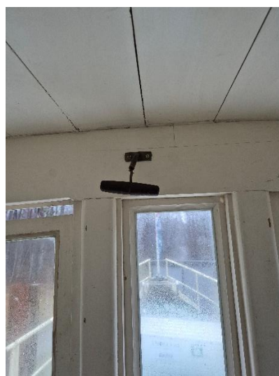
Håndtaket til dampfløyten i forkant av skorstein.
