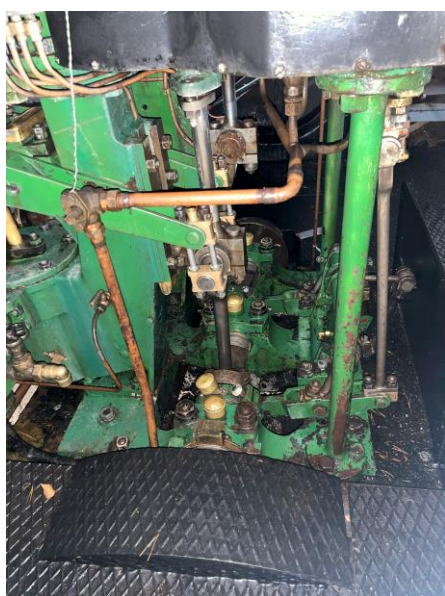
Maskinen med dreneringsrør i forkant. Forhøyning i dørken for lager på veivaksling.
