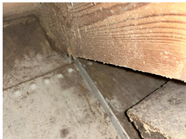
Betongballast under mannskapslugar.
