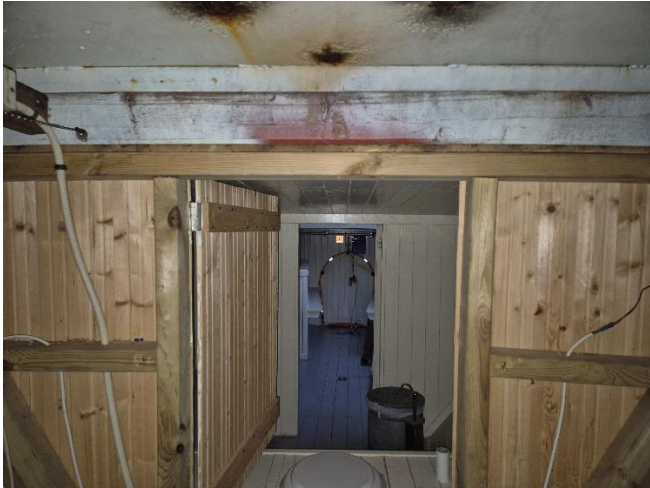
Forpiggen, skottet inn mot toalettrom.
