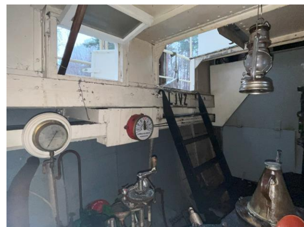
Til venstre: Vakuummåler, til høyre maksintelegraf. Nederst til venstre – smøreapparat til høytrykkssylinder. Babord side. Oppgang fra maskinrom til dekk.
