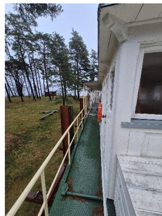
Rekkverk, rørgjennomføringer kjettingstyring. Styrbord side.
