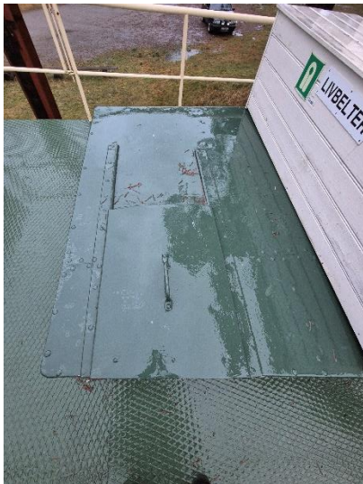
Skyvedør til åpning av nedgangskappe, mannskapslugar. Babord side.
