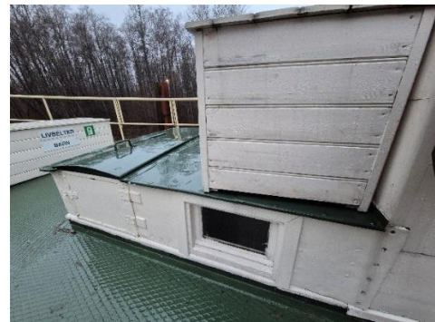
Låsbar nedgangsluke og lysventil til casing, mannskapslugar.
