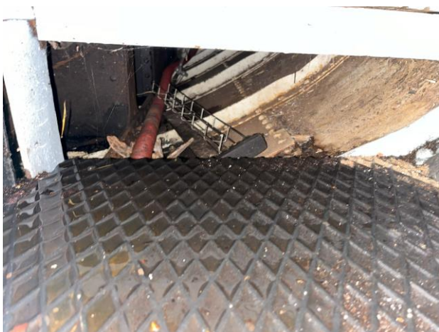
Rista under/ved kjelen.
