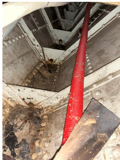
Kjøl og spant, under mannskapslugar.
