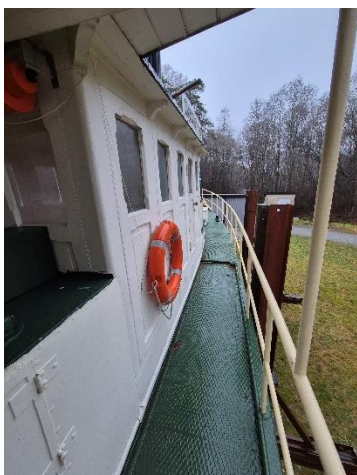
Kjele casing/styrhus not fordekket, styrbord side.
