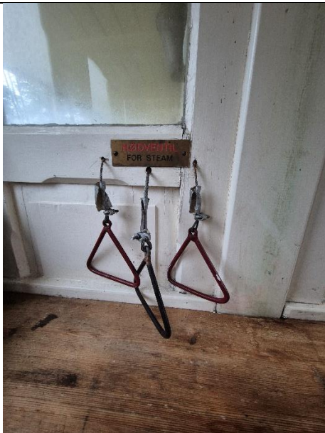
Til nødstop av dampen i kjelen.
