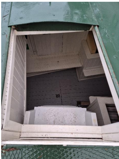
Nedgang til mannskapslugar fra dekk.
