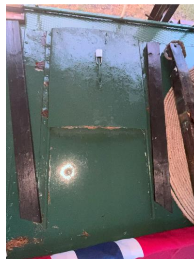
Nedgangskappe, skipper- og maskinslugar.
