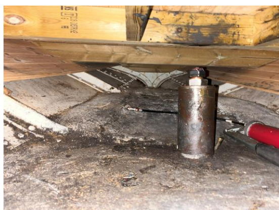
Tilgang rorgjennomføring under tunnelinngang akter.
