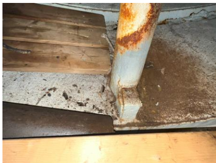
Rorgjennomføring og betongbalast.
