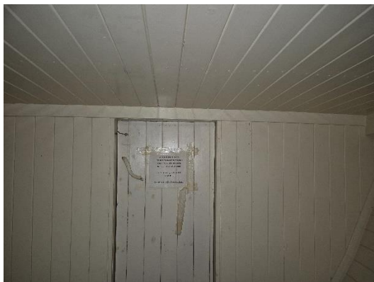
Toalett, dør inn til mannskapslugar.
