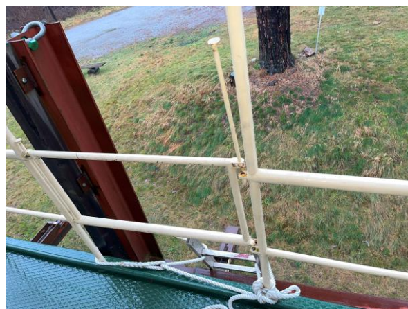
Portåpning i rekka, styrbord side.
