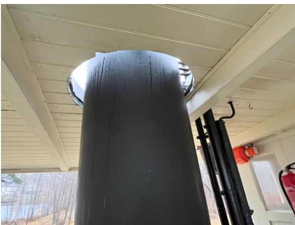
Skorsteinsgjennomføring – takoverbygning over deler av dekk akter.
