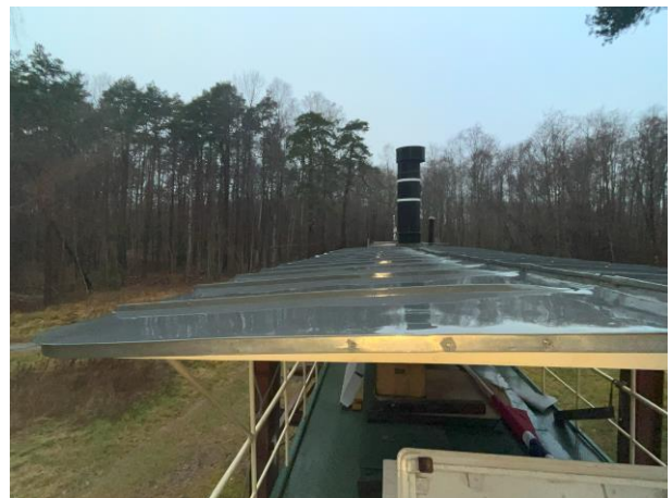
Plategledning, takoverbygget – akter.
