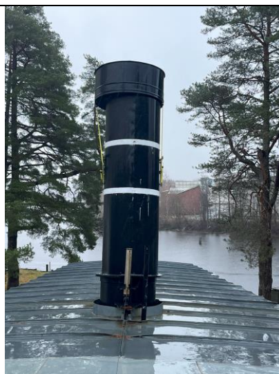
Skorstein og skipsfløyte, takoverbygning, dekk.
