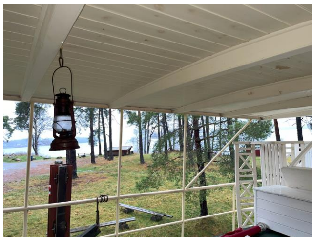
Bjelkelag og taktro, himling – takoverbygg.
