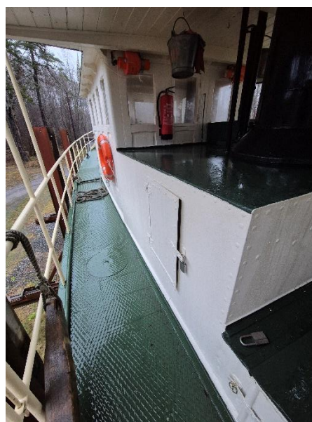
Casing til kjele med inspeksjonsluke, forut.
