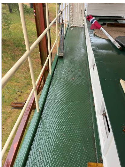
Casing, rifledekk og rekke, akter, styrbord side.
