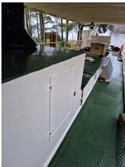
Casing til kjele med inspeksjonsluke, akterover.
