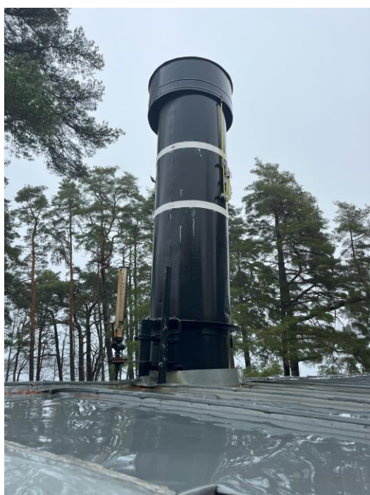
Skorstein og skipsfløyte.
