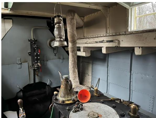
Toppen av maskinen. Hoveddamprør fra kjele til maskin.
