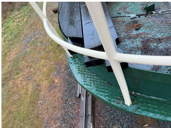
Rekkesepter ved dollbordet/dekk akter, styrbord side.
