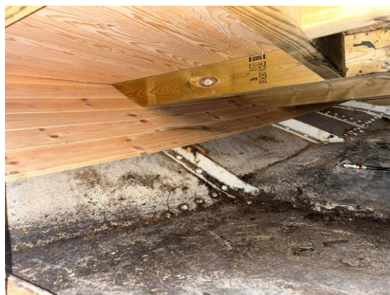
Tilgang rorgjennomføring under tunnelinngang akter.
