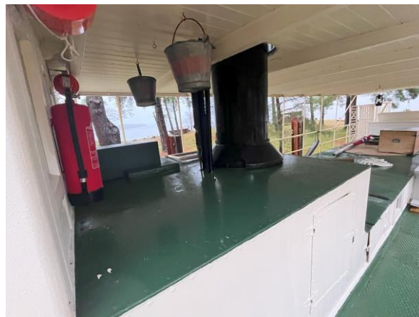
Gjennomføring skorstein, babord side.
