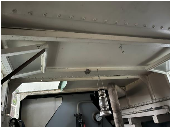
Klinket bjelkelag i maskinrom
