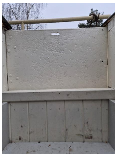
Nedgang casing – til mannskapslugar.
