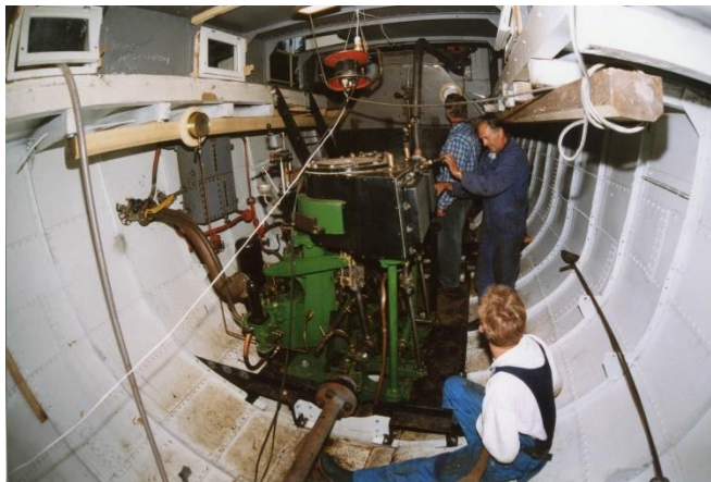
Dampmaskinen settes på plass under kyndig ledelse av Dahl fra Drammen Skipsreparasjoner AS. Foto: Tilhører Jørn Fjeld.
