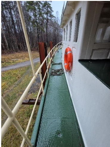
Styrhus og kjele casing – babord side.
