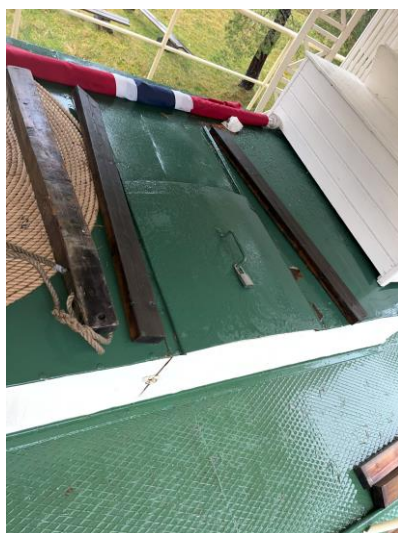
Nedgangskappe, skipper- og maskinslugar.
