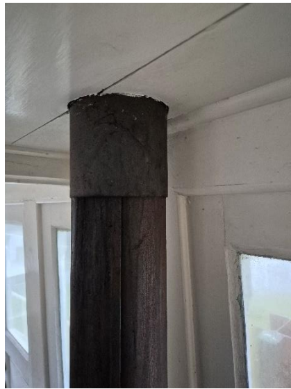
Rørgjennomføring til vedkomfyr.
