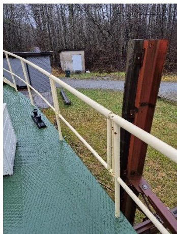
Rifledekk, erstattet tredekket i 1958.
