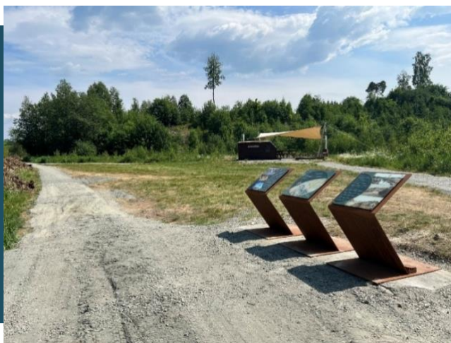
Såkalte Z-skilt kan fundamenteres både over og under bakken. Foto: Hanne Huseby
