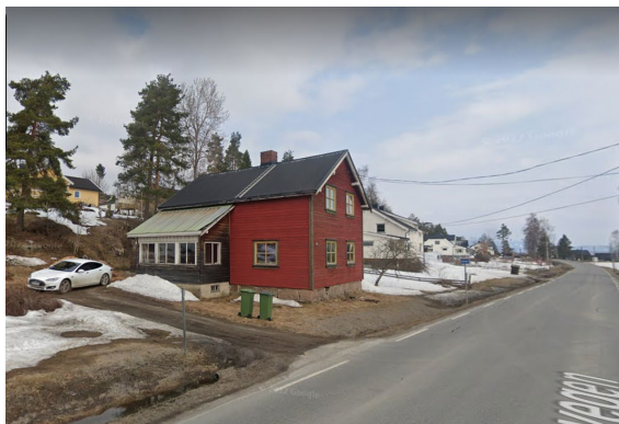
Figur 5.7. Skogset sett fra sør. (Kilde: Google streetview)
