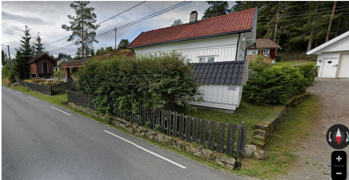
Figur 5.17. Åsvegen 418. Stabbur er tett på veien. (Kilde: Googlestreetview.no)
