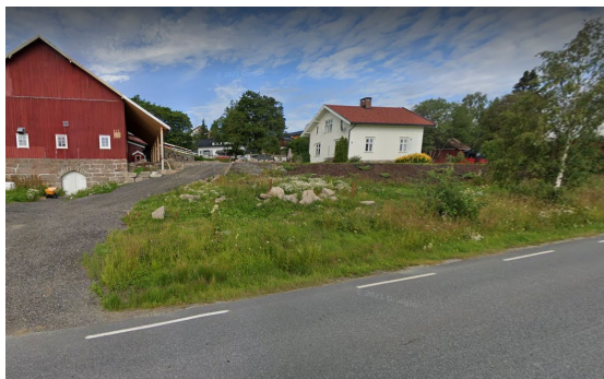
Figur 5.12. Kåråsen nr.3. Driftsbygg til venstre, våningshus i midten og stabbur til høyre bak bjørkene. De to førstnevnte er SEFRAK-registrerte. (Kilde:Goolemaps.no)
