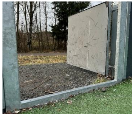
Det er ikke trinnfri gangatkomst inn til ballbingen.
