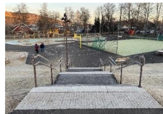
Trapp med håndløpere, kontrastmarkering på inntrinn, farefelt og oppmerksomhetsfelt.
