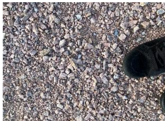
Dekket med grus har for grove fraksjoner, for lite finstoff og derfor ikke trillefast.
