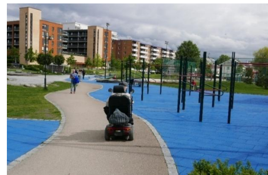
Trinnfri gangatkomst gjennom anlegget og helt frem til aktivitetsflatene. Gangforbindelsen har visuell (synlig) og taktil (følbart) avgrensning.
