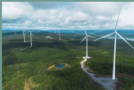
Figur 4-6: Odal vindkraftverk. Kilde: energiwatch.no
